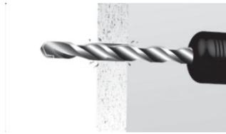
**1.** Percer au diamètre 10mm
